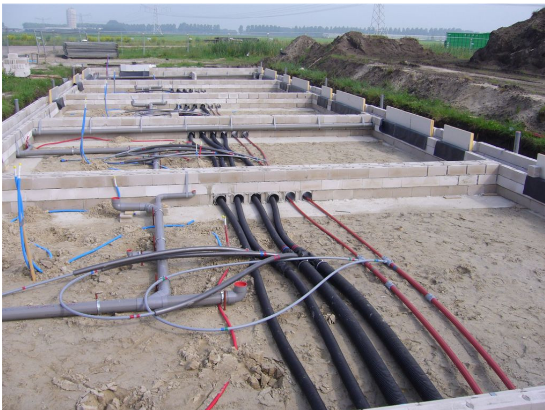
Figuur 6. Warmte- warm tapwater en koudeleidingen in een project met grondgebonden woningen in De Beljaart, Dongen.
