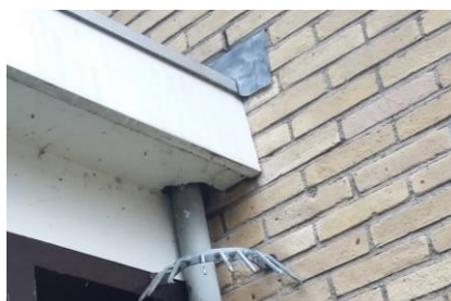
Houtwerk van dichtbij. Boven loodslab ventilatievoeg
