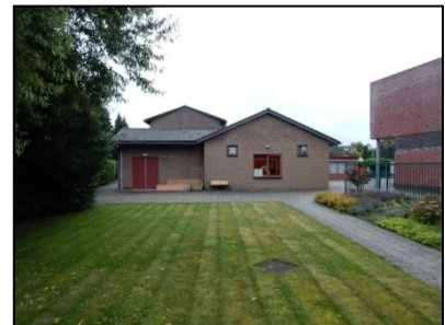
Figuur 5. Achterzijde onderzoekslocatie.
