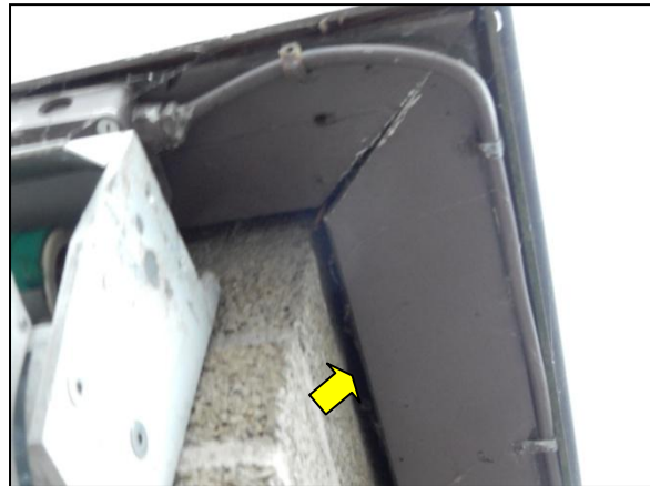
Figuur 14. Ruimte achter betimmeringen.
