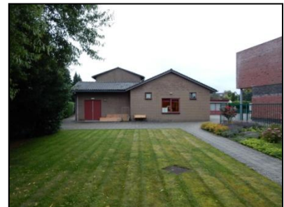
Figuur 5. Achterzijde onderzoekslocatie.
