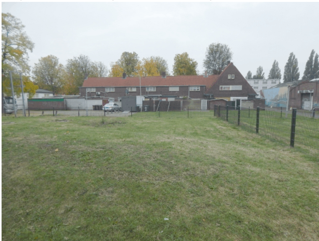
Plangebied - woonbebouwing vanaf het noordwesten gezien
