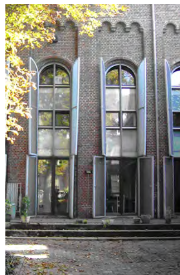
begane grond met overhoogte
