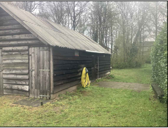
Locatie G3 en G4 (zuidzijde schuur)
