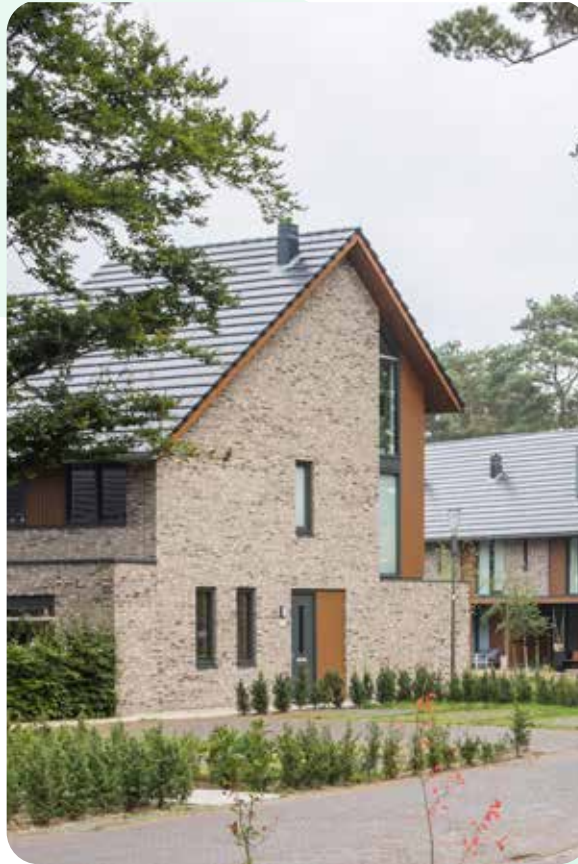
Kopgevel aan openbare ruimte heeft een open structuur en gevelopening
