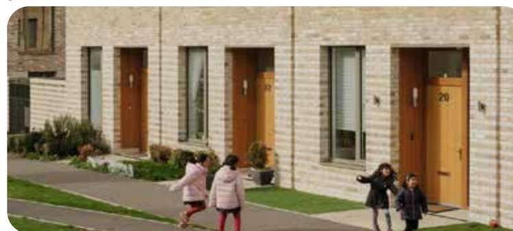
Dieptewerking in de gevel door terugliggende gevelopeningen/entree
