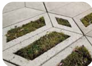
Waterpasserende verharding met verschillende vullingen
