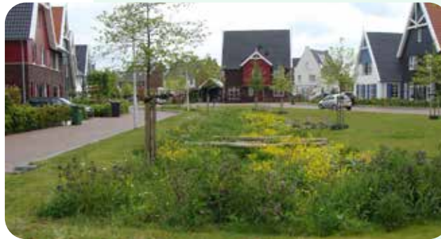
Wadi met bomen en wadimengsel
