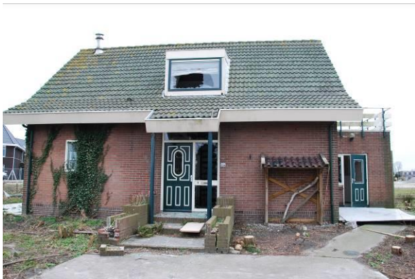
Figuur 3.5. Poelkade 44a, reeds gesloopt onder ecologische begeleiding
