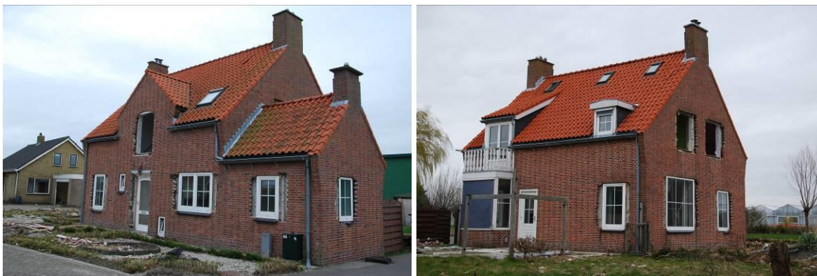
Figuur 3.6. Poelkade 32a, woning met huismussenverblijven en mogelijk een vleermuisverblijf
