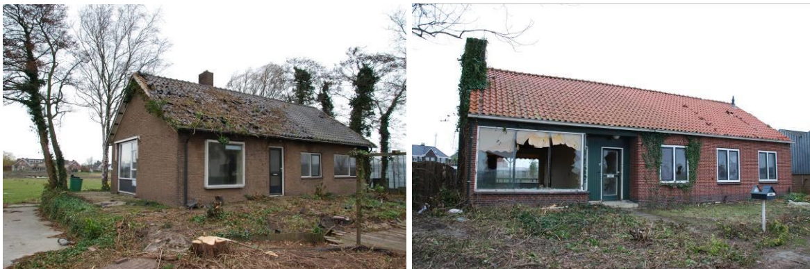
Figuur 3.4. Links: Poelkade 18 rechts: Poelkade 44, beide reeds gesloopt onder ecologische begeleiding.
