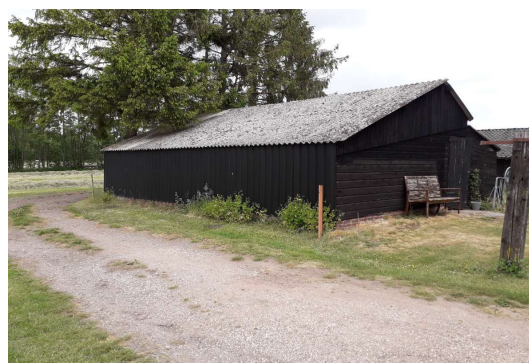
Loods met asbestverdachte dakbedekking
