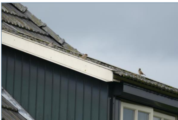
Foto 1. Huismussen op dakkapel (Aaltenseweg 99).
