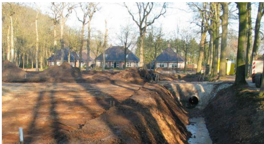
Aanleg van een gracht
