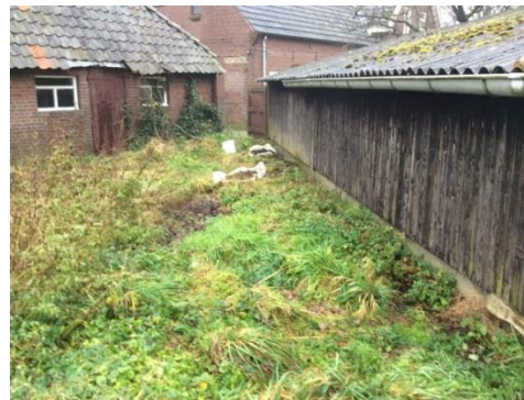
Figuur 9: Dak(goot) bebouwing
