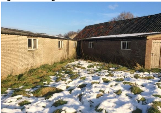
Figuur 8: Overzichtsfoto bebouwing
