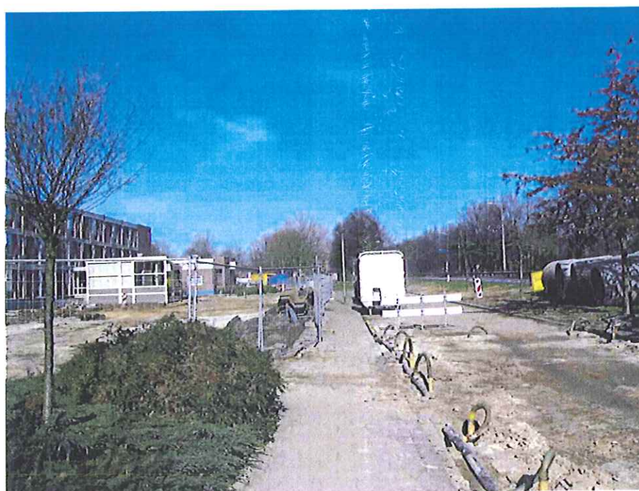
Foto 8 Brugske – werkzaamheden aan weg en bij St. Joseph
