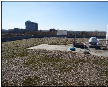
Figuur 9. Dak van het archief.
