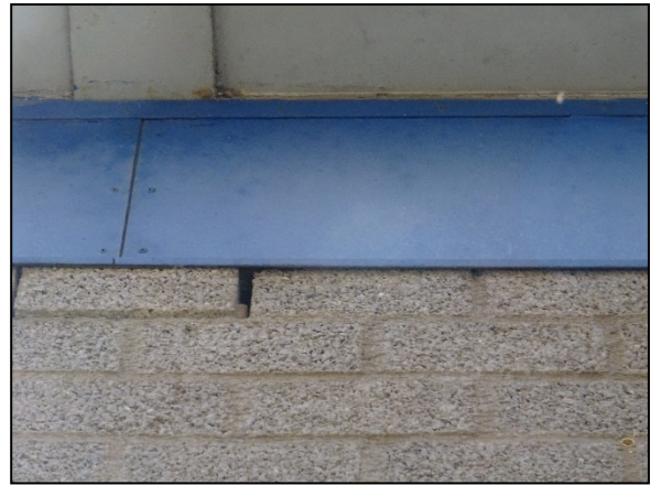
Figuur 18. Open stootvoeg, die toegang geeft tot de gevel.
