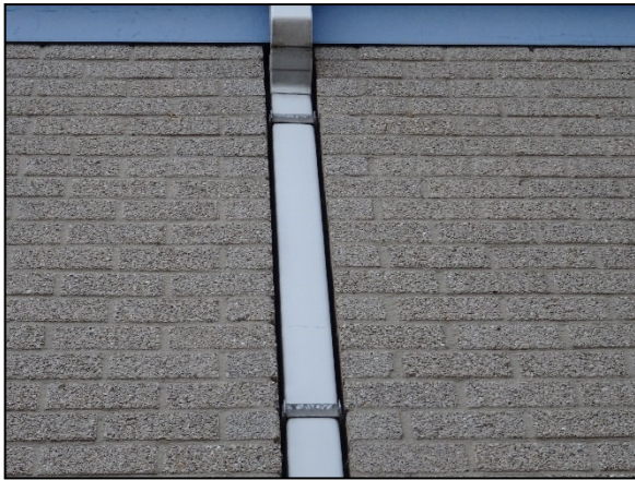
Figuur 17. Ruimte achter regenpijp geschikt voor vleermuizen.
