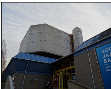
Figuur 3. Ingang museum aan noordzijde met daarbovenop het archief.
