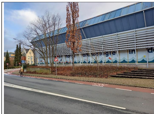
Fotonummer: 13: West-nordwestzijde onderzoekslocatie
