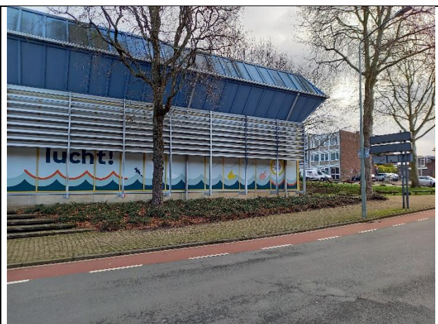
Fotonummer: 14: West-zuidwestzijde onderzoekslocatie
