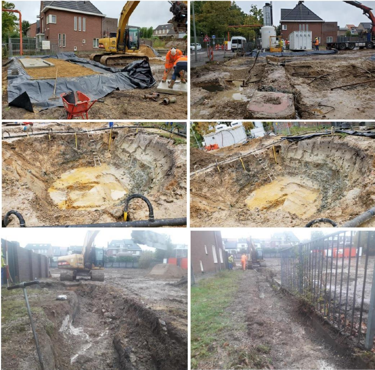
Figuur 21: Beeld van de saneringswerkzaamheden ter plaatse van het plangebied in oktober-november 2019. 38
