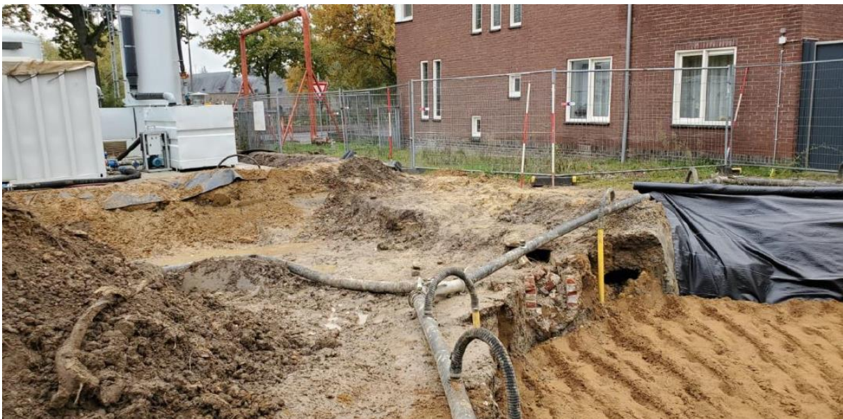
Figuur 20: Bodemsaneringswerkzaamheden binnen de zuidwestelijke hoek van het plangebied. 37
