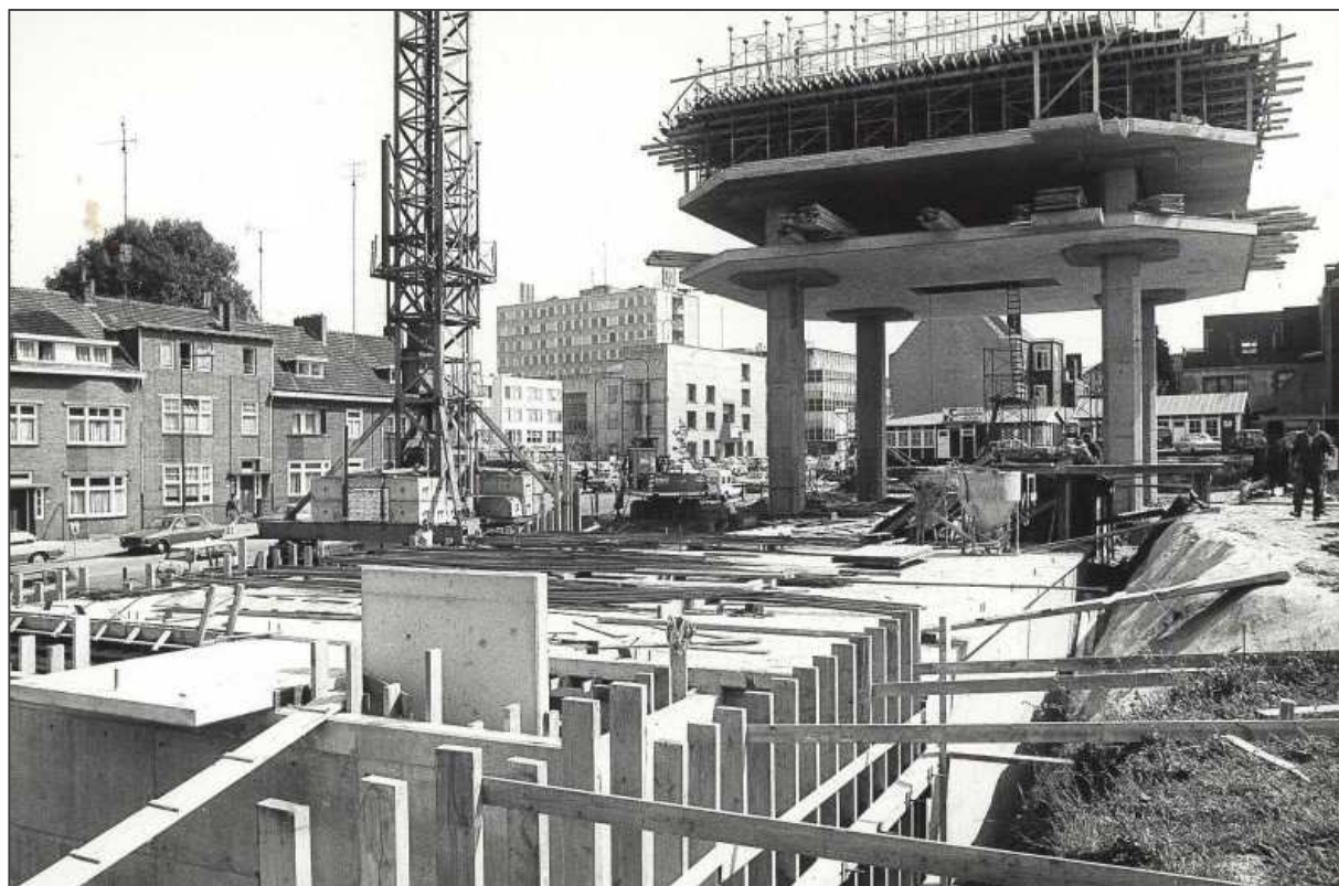
Figuur 19. Opname tijdens de bouw vanuit het westen, met rechts het steile talud van de bouwput. Bron: archief Thermenmuseum.
