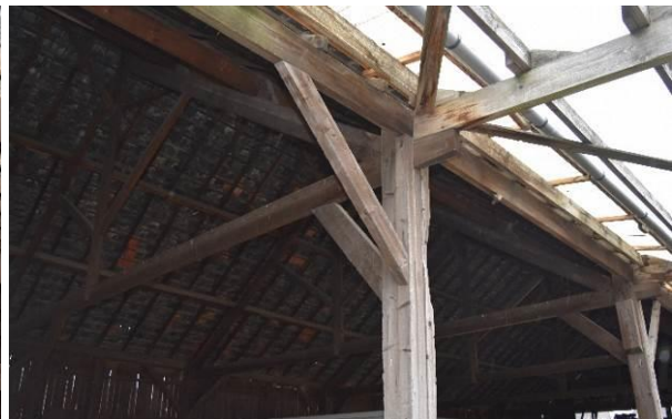
Rechts: één van de gebintstijlen met de aansluiting van de afgeschoorde, overstekende dekbalk. De langskoppelbalk heeft windschoren.
