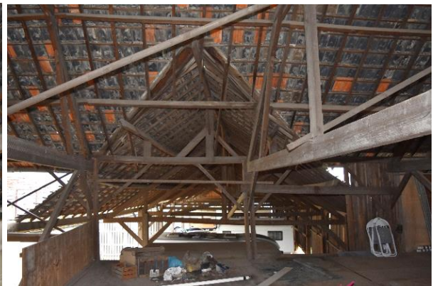
Links: de hulpconstructie bij de aansluiting van de kap van loods 5 op de kap van loods 4, gezien vanuit loods 5.
