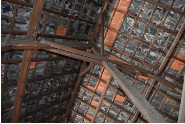
Overzichten van de nok van loods 4. Op de foto zijn de dubbele koppelbalk en de afgeschoorde nokbalk herkenbaar.
