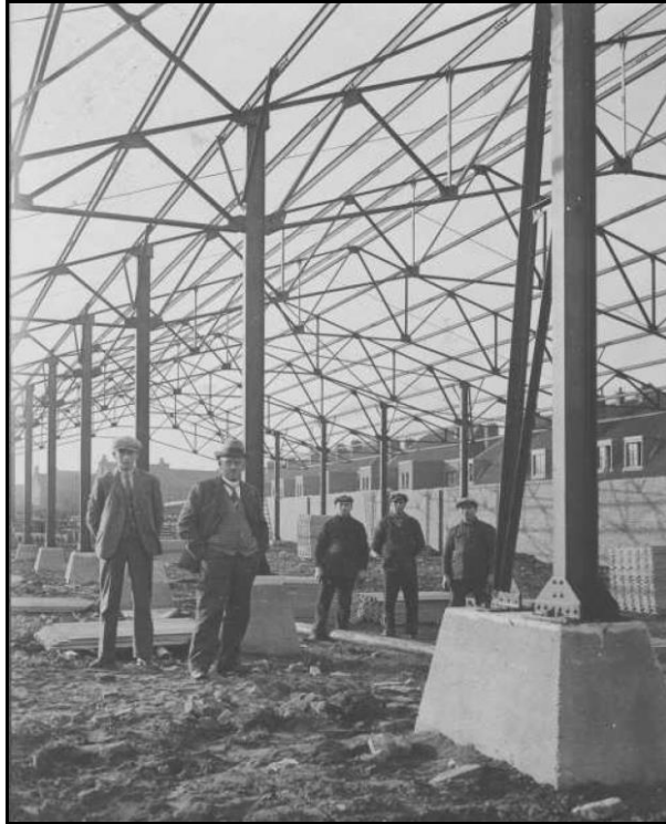
De gemonteerde staalconstructie van de loods van de firma Doyen in 1930 (Franck 2010, pag. 15).
