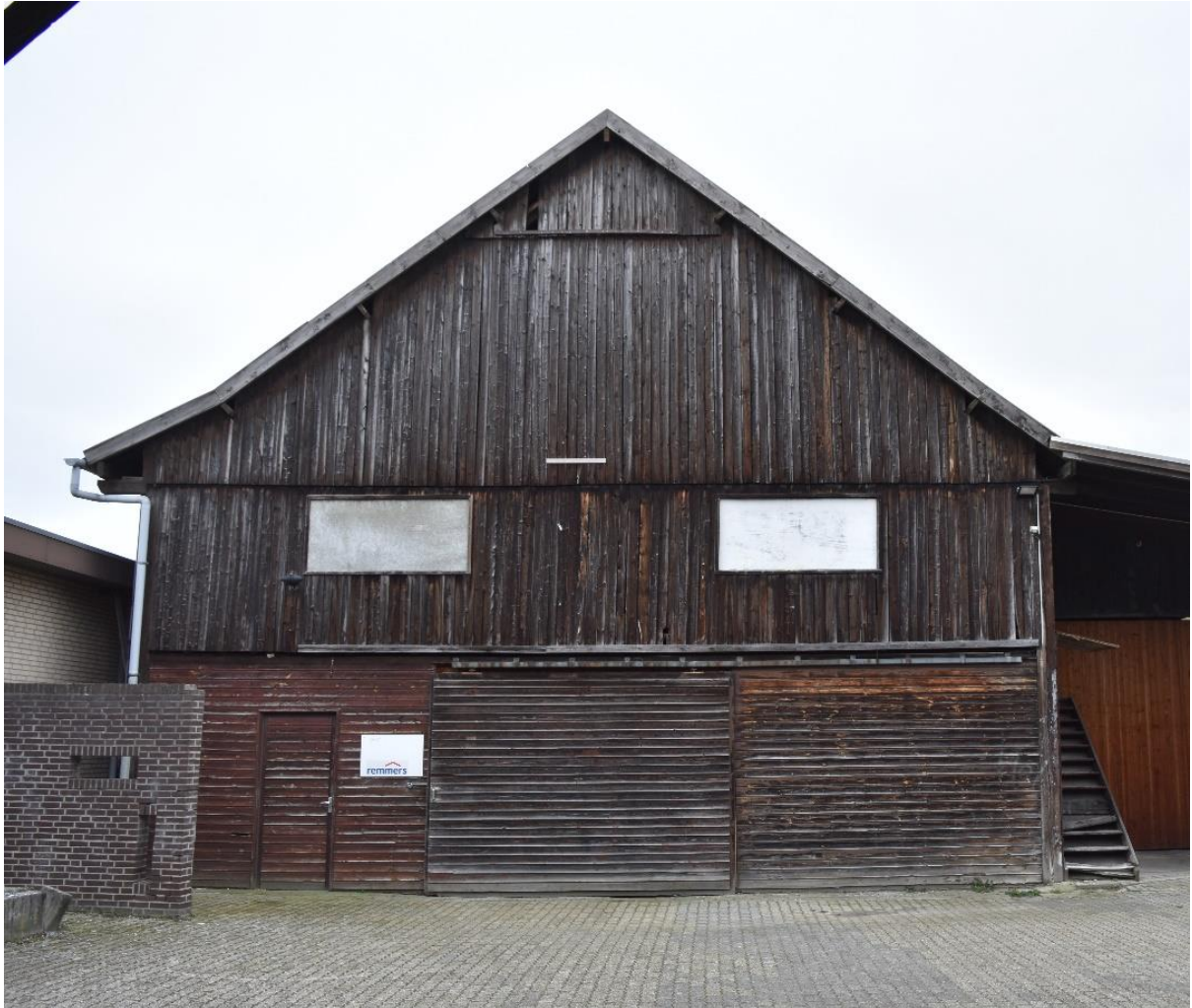
De tweede houtloods op het terrein aan de Willemstraat (1915). Vermoedelijk is deze loods oorspronkelijk afkomstig van het terrein aan het Kerkhof (gebouwd in 1902) en hier herplaatst. De aanbouwen aan de rechterzijde zijn van jongere datum.
