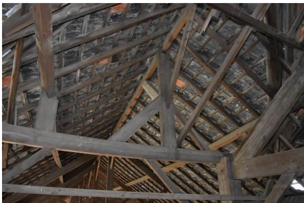
Rechts: één van de gebintstijlen met de aansluiting van de afgeschoorde, overstekende dekbalk. De langskoppelbalk heeft windschoren.
