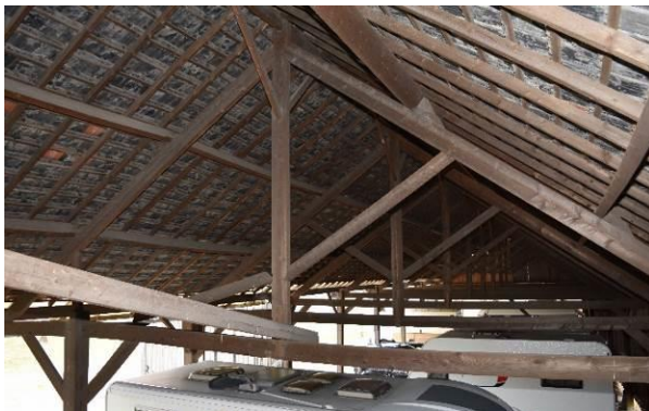
Links: overzicht van de kapconstructie van loods 5.
