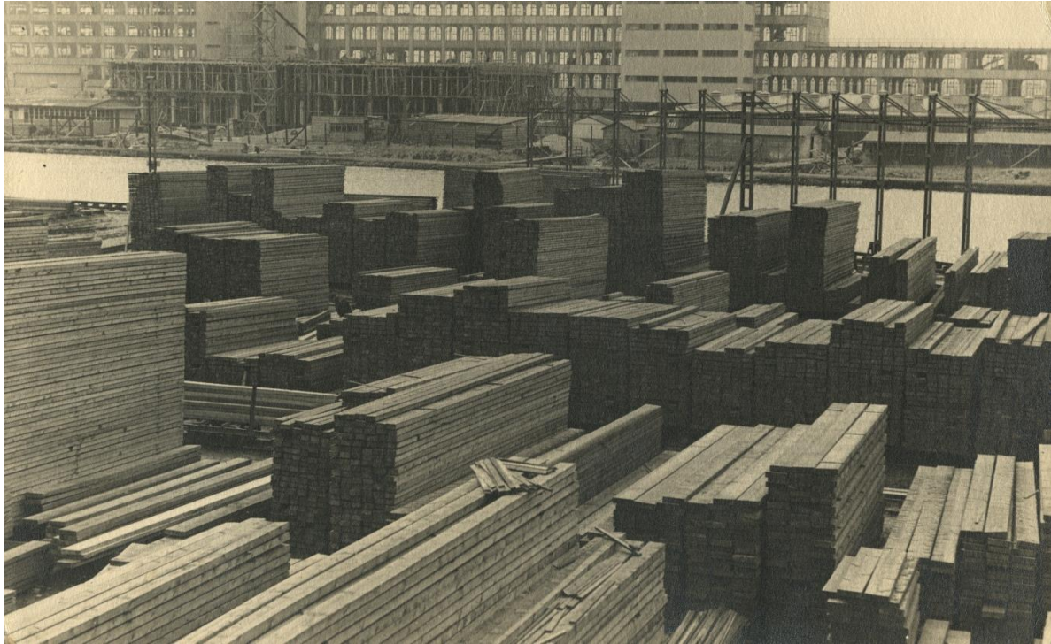
Opslagterrein met stapels gezaagde planken van houthandel Abraham van Stolk aan de Delfshavense Schie in Overschie, foto Andor von Barsy omstreeks 1926 (Stadsarchief Rotterdam, 4002 Collectie Havenbelangen, 1925-1985, nr. NL-RtSA_4002_FD-3124).
