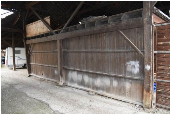
Links: de doorrit door loods 4. De magazijnen op de begane grond hebben gesloten wanden, bestaande uit een tussenstijl, regels en verticaal beschoot.
