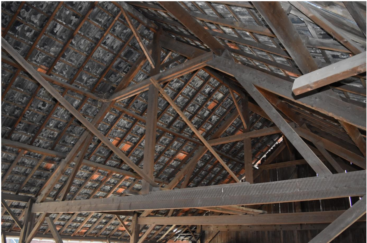
Overzicht van de kapconstructie van loods 4.
