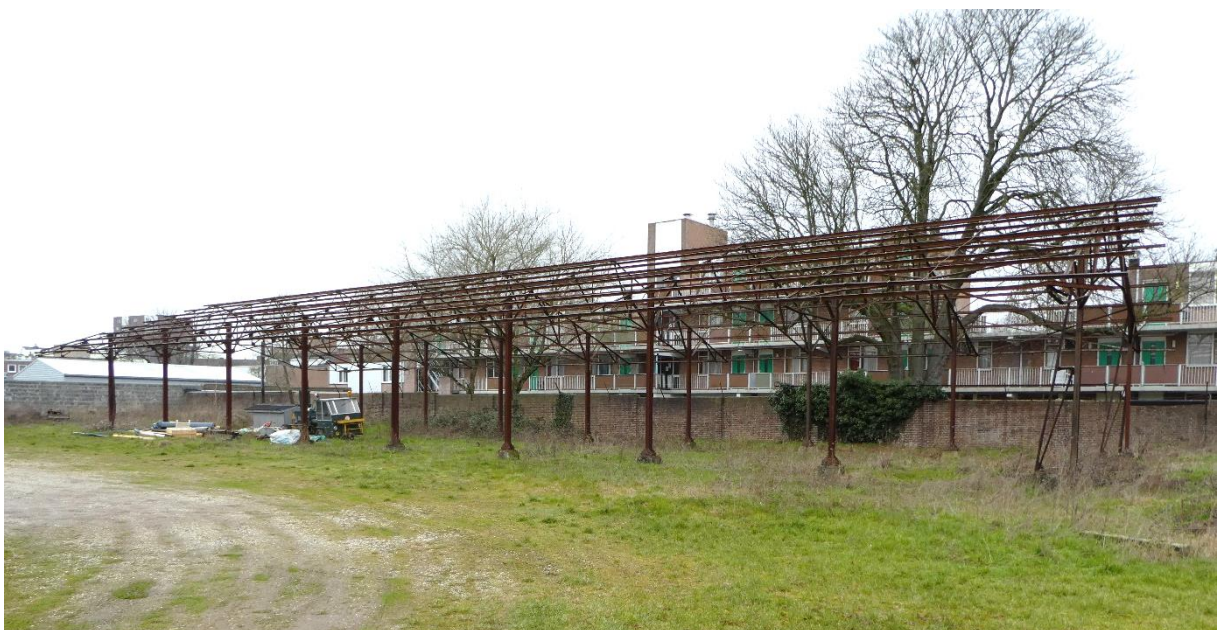
Overzicht van de constructie van de stalen loods na verwijdering van de asbest golfplaten.
