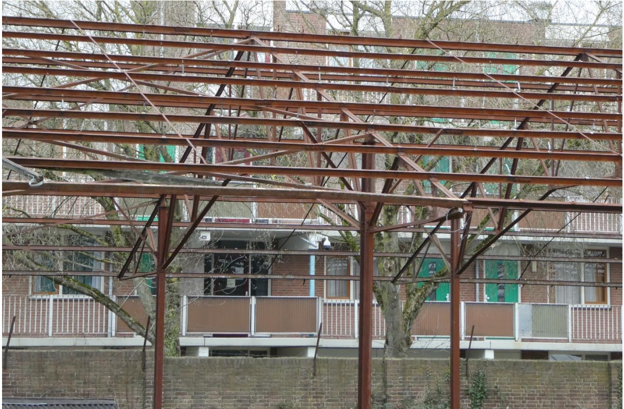
Deeloverzicht van de stalen loods na verwijdering van de asbest golfplaten.
