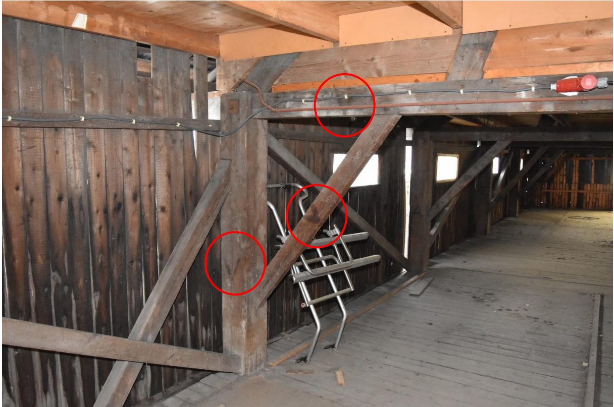
Gebint V op de eerste verdieping van loods 2. Op deze foto zijn de posities van de geschilderde merken aangeduid met rode cirkels.
