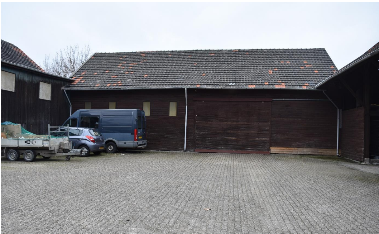
De voorgevel van loods 3. Het beschot van rabatdelen en de schuifdeur zijn vermoedelijk secundair.
