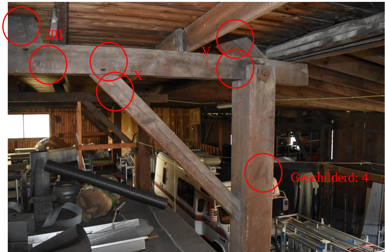
Gebint 4 op de eerste verdieping. Op de stijl is het geschilderde nummer 4 duidelijk herkenbaar. Op de dekbalk zijn paringsmerken herkenbaar: III en V.
