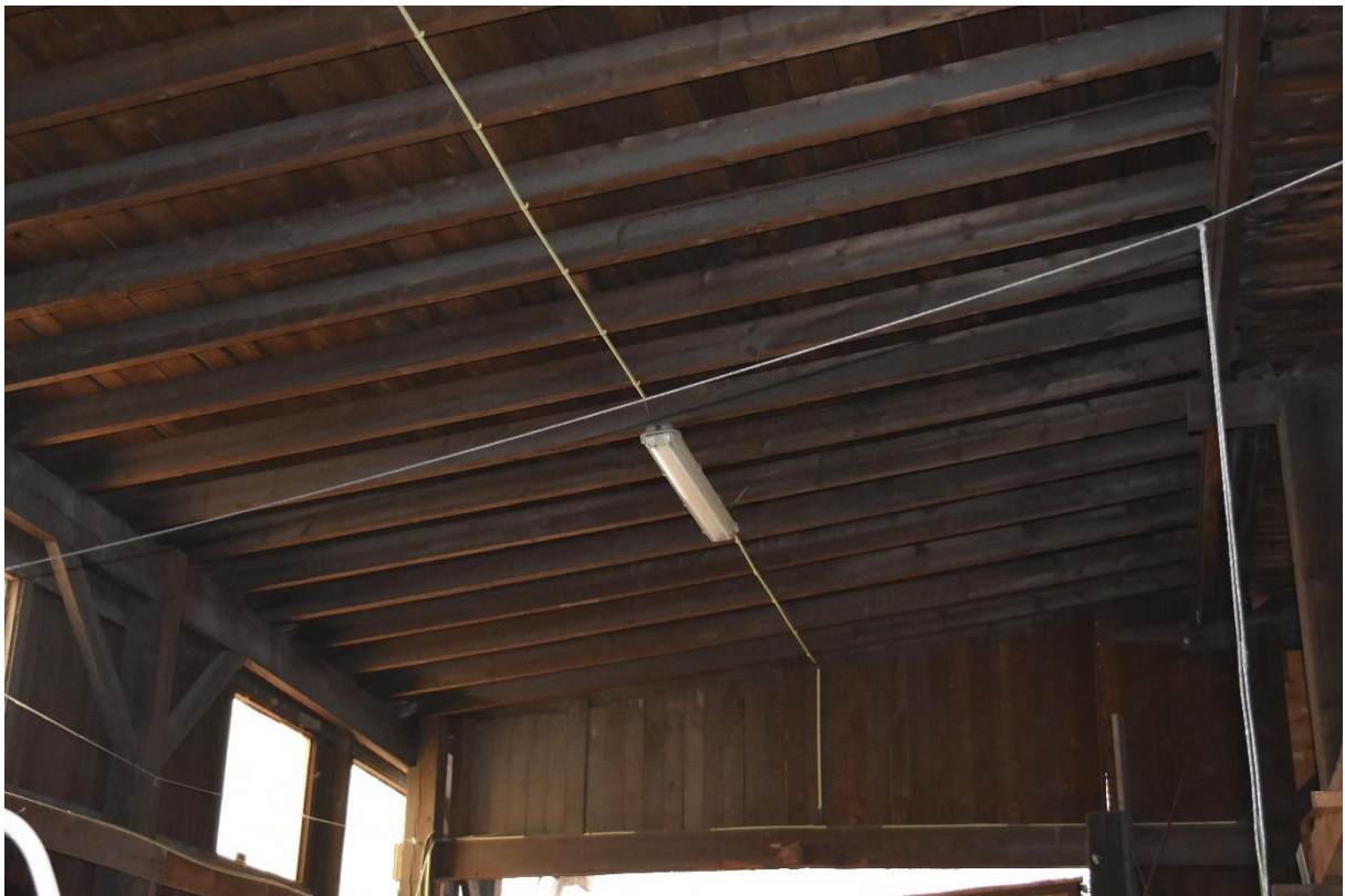
De constructie van het lessenaardak van de overkapping.
