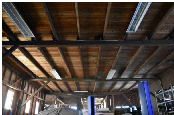
Links: de debalken op de gebinten van loods 3 kragen uit ter plaatse van de aansluiting op de stijlen ten behoeve van een overstek van het dak. De kopeinden van de debalken zijn geprofileerd.
