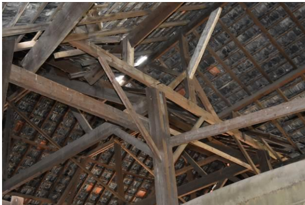
Links: de hulpconstructie bij de aansluiting van de kap van loods 5 op de kap van loods 4, gezien vanuit loods 5.
