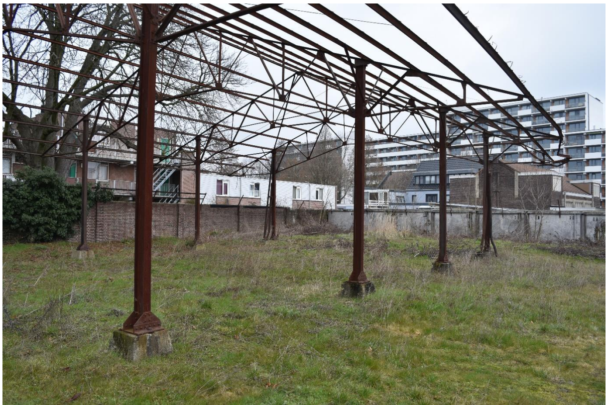
Overzicht van de stalen loods na verwijdering van de asbest golfplaten.
