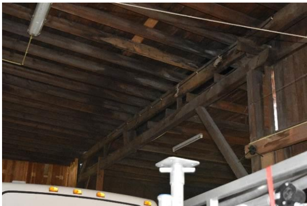
Links: overzicht van het gebint ter plaatse van westelijke kopgevel van loods 3. Vlak boven de debalk van het gebint is een strijk balk herkenbaar, onderdeel van de constructie van het lessenaardak van de overkapping tussen de loods 2 en 3.
