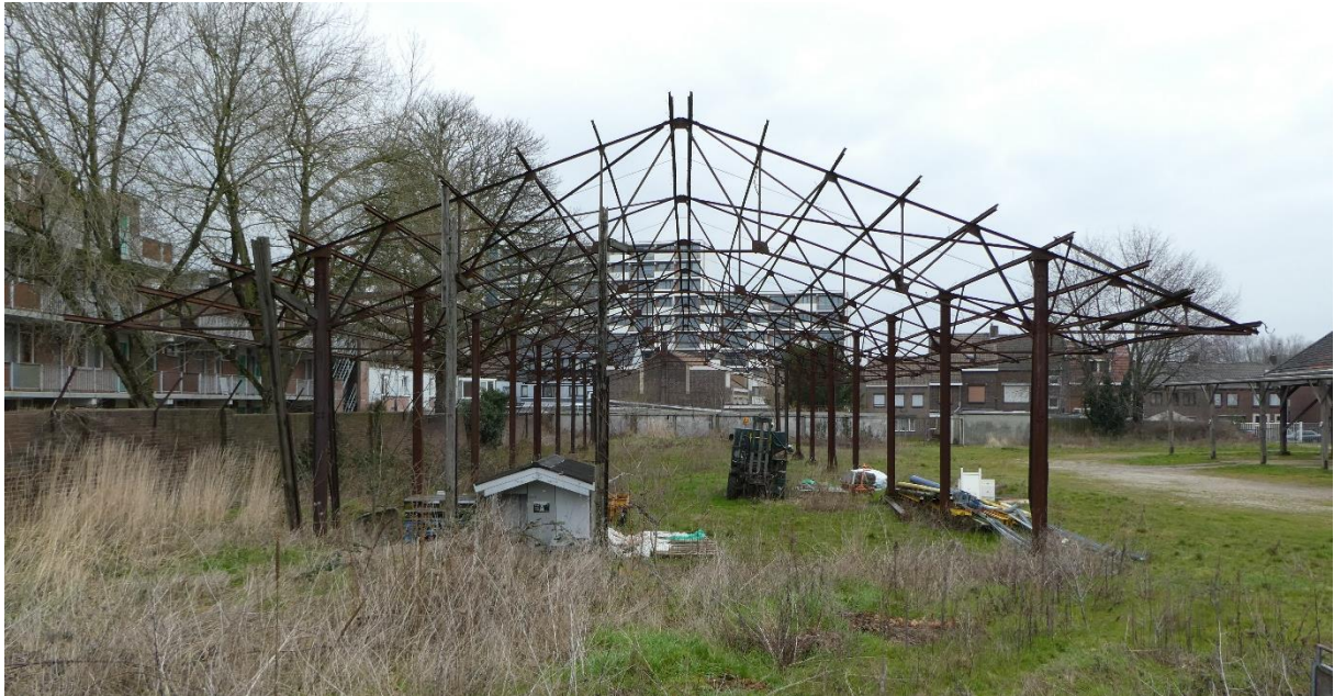
Overzicht van de stalen loods na verwijdering van de asbest golfplaten. Deze platen zijn verwijderd omstreeks 2012.
