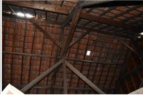
Links: de kruisende diagonale windverbanden tussen de spanten in loods 1.
