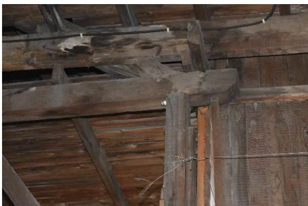
Links: de debalken op de gebinten van loods 3 kragen uit ter plaatse van de aansluiting op de stijlen ten behoeve van een overstek van het dak. De kopeinden van de debalken zijn geprofileerd.
