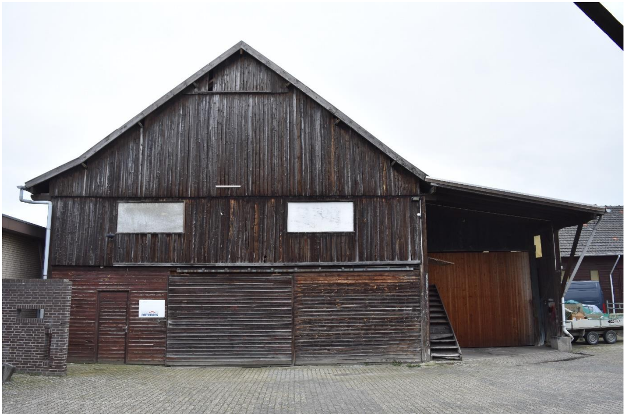
De zuidelijke kopgevel van loods 2. Opvallend is de afwijkende invulling van de begane grond met horizontale rabatdelen, wellicht vanwege het afzonderlijke gebruik van de begane grond. Rechts tegen de oostelijke langsgevel staat een overkapping uit 1922.
