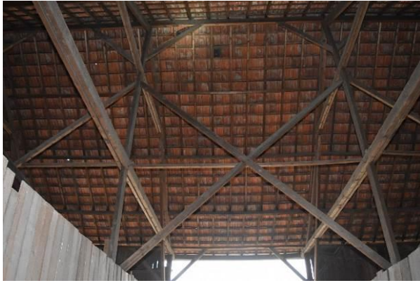
Links: de kruisende diagonale windverbanden tussen de spanten in loods 1.
