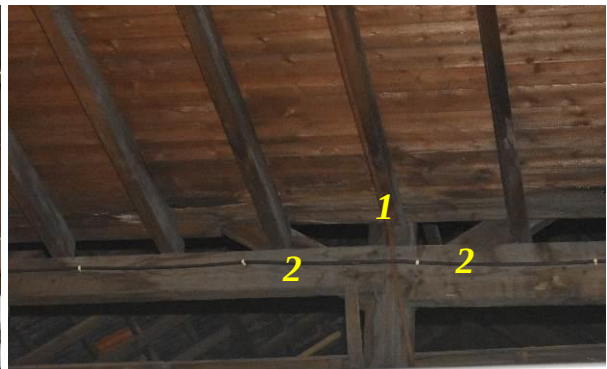
Links: overzicht van het gebint ter plaatse van westelijke kopgevel van loods 3. Vlak boven de debalk van het gebint is een strijk balk herkenbaar, onderdeel van de constructie van het lessenaardak van de overkapping tussen de loods 2 en 3.
