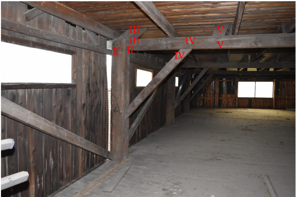
Gebint 4 op de eerste verdieping van loods 2. Op de stijl, dekbalk en korbeel zijn geschilderde nummers 4 herkenbaar. Op deze foto zijn de aangetroffen gehakte paringsmerken aangeduid.
