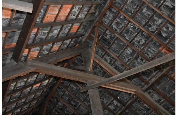
Overzichten van de nok van loods 4. Op de foto zijn de dubbele koppelbalk en de afgeschoorde nokbalk herkenbaar.
