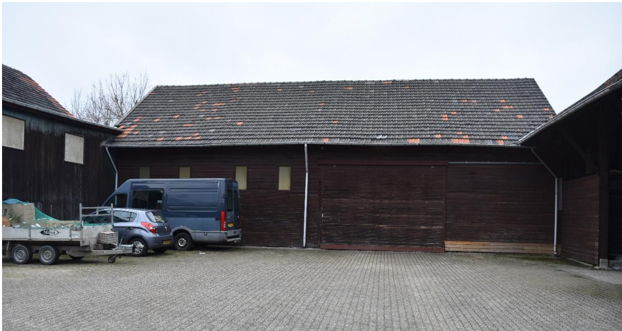
Loods 3 op het terrein aan de Willemstraat. Deze loods was aan de linkerszijde aanvankelijk één travee langer. Deze travee is gesloopt voor plaatsing van een overkapping in 1922.
