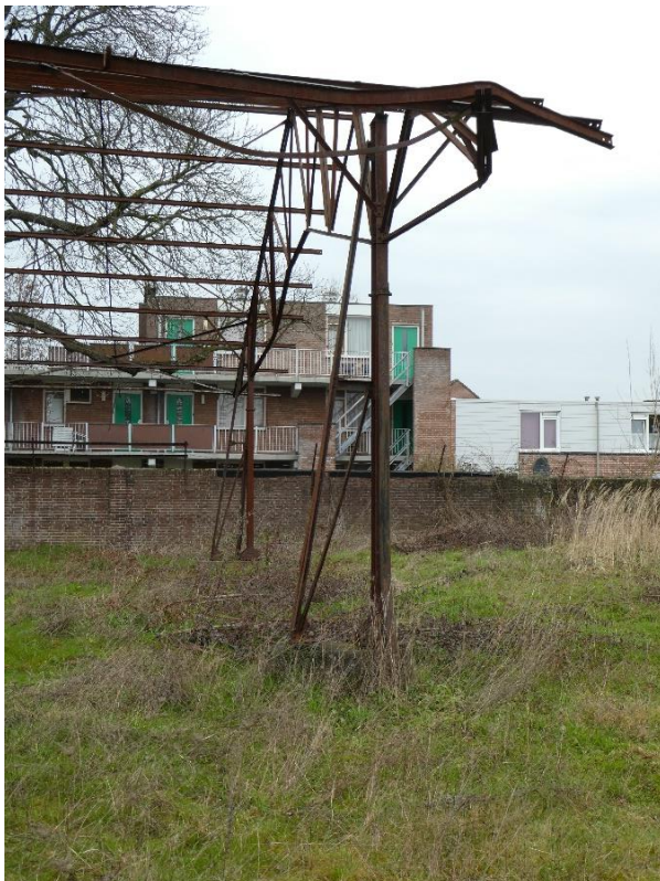
Links: het afgeschoorde kopsant van de stalen loods.
