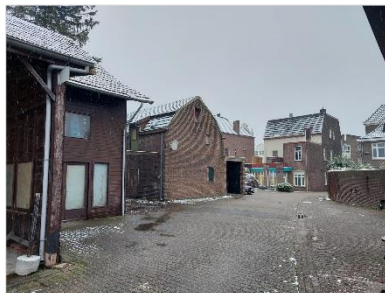
Figuur 2-4. Bebouwing op de onderzoekslocatie. (Kijkrichting West).
