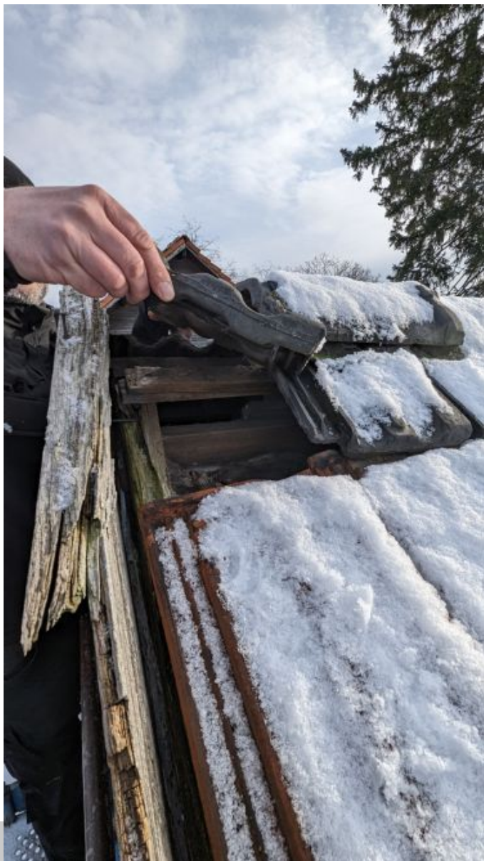
Het pannendek van gebouw 8. Er is hier geen dakbeschot aanwezig, waardoor direct onder het pannendek geen vogels kunnen verblijven of er een nest kunnen bouwen.
