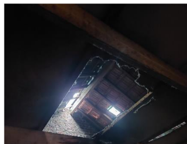
Figuur 2-8. Verouderde bebouwing op de onderzoekslocatie, binnenzijde.
