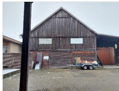
Figuur 2-5. Bebouwing op onderzoekslocatie bestaande uit houten muren en met dakpannen zadeldak belegd.
