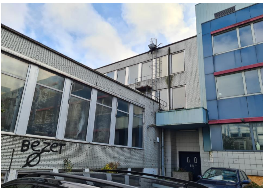
Figuur 5: Bebouwing gezien vanaf de binnenplaats
