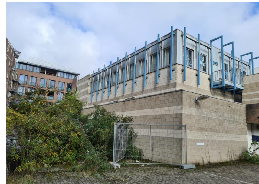
Figuur 4: Bebouwing gezien vanaf de binnenplaats
