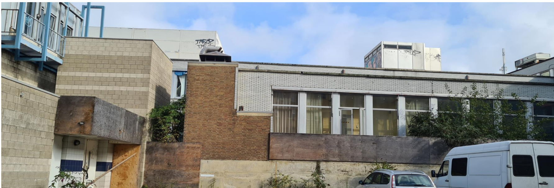
Figuur 3: Bebouwing gezien vanaf de binnenplaats
