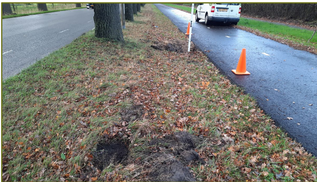
Afbeelding 35. Profielkuil in de berm tussen de rijbaan en het fietspad
