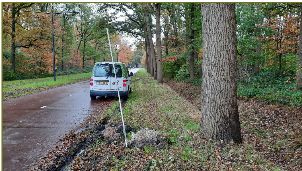
Afbeelding 44. Profielkuil ter hoogte van boom 259
