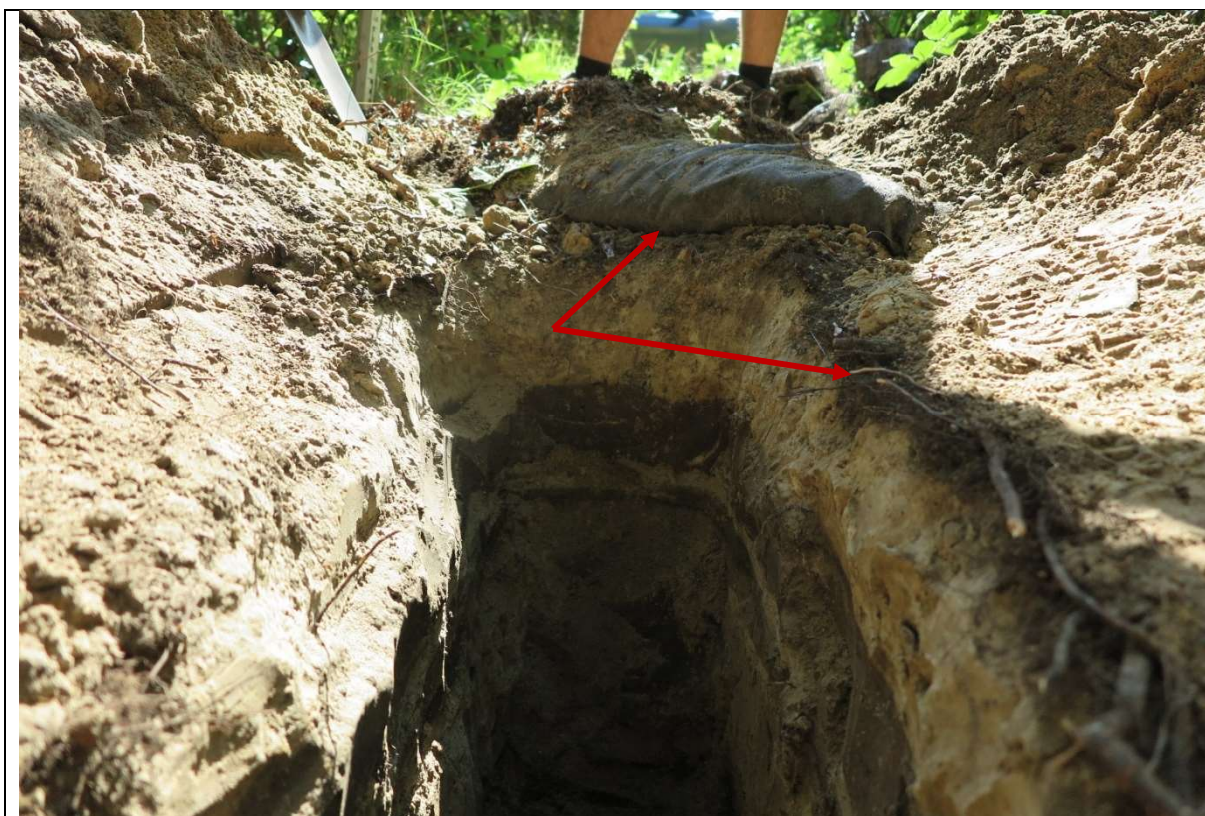
Antiworteldoek en dunne, intensief bewortelde laag
