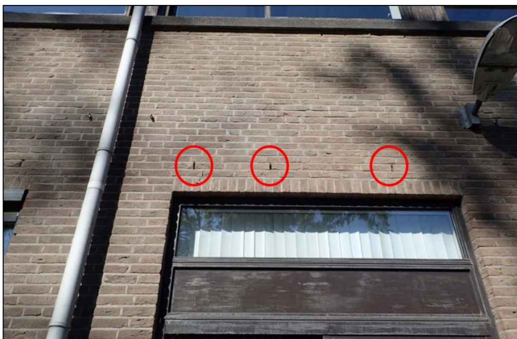
Figuur 1.3 Middels open stootvoegen kunnen vleermuizen toegang krijgen tot potentiële verblijfplaatsen in de bebouwing op de planlocatie.
