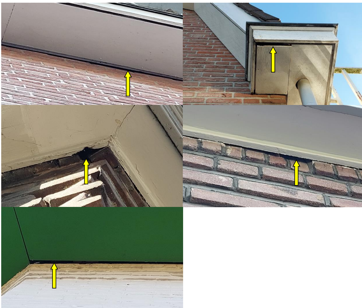
Figuur 4.4.6. Vleermuizen kunnen via meerdere spleten de gebouwen in: boven= westelijke zijgevel van de woning van het bestratingsbedrijf, midden=meerdere spleten tussen de gootbetimmering en de gevel van de woningen en onder=meerdere spleten tussen de gootbetimmering en de gevel van het bedrijfspand.
