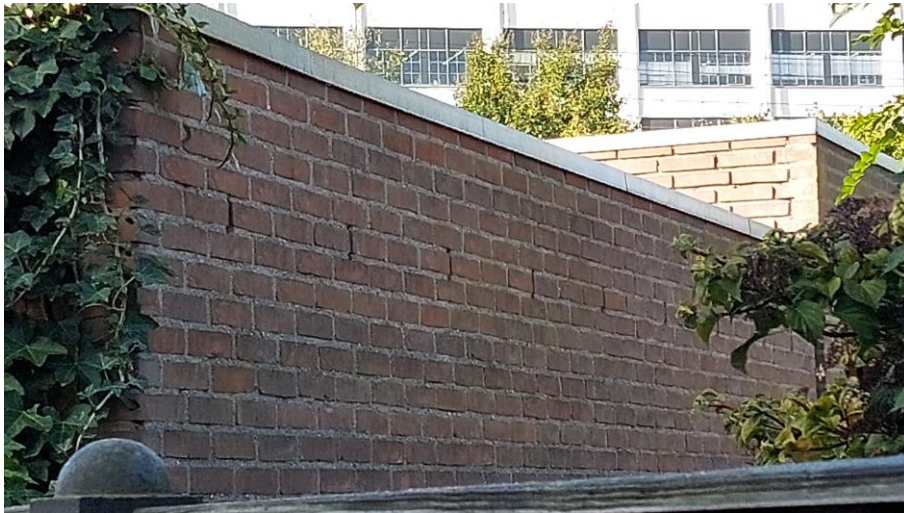
Figuur 4.4.1. Open stootvoegen in de noordelijke gevel van het kantoorpand verlenen aan vleermuizen toegang tot de spouw.
