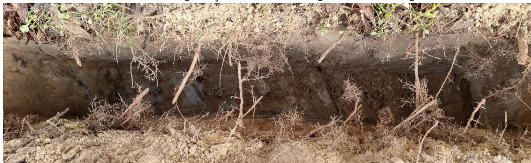
Foto 6. Beeld van beworteling nabij boom 5879 ter hoogte van het te ontgraven cunet
