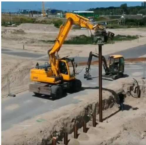
Afbeelding 5: Het indrukken van een stalen grondkering/damwand
