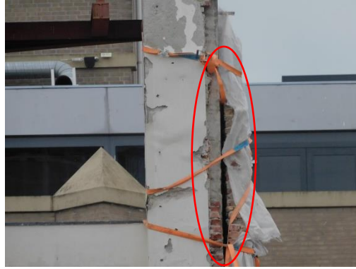
Open spouw oostzijde van de muur
