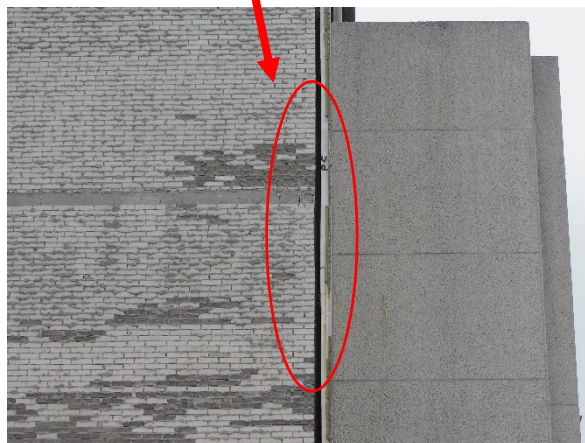
Open spouw oostzijde van de muur
