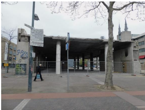
Betonnen geraamte parkeergarage zuidzijde
