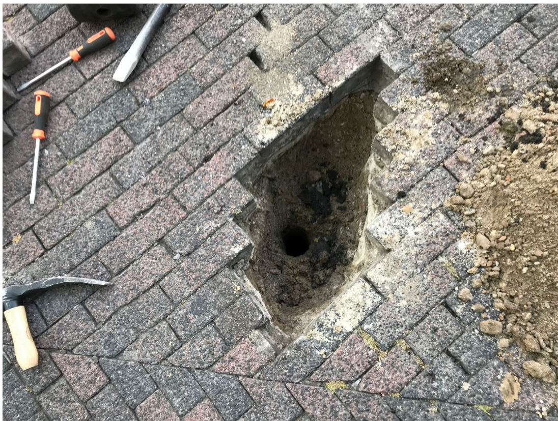
Figuur 6: De wortelloze profielsleuf ter plaatse van de graafgrens van de te ontgraven parkeerkelder, binnen de kwetsbare zone van de platanen aan het Begijnenhof.
