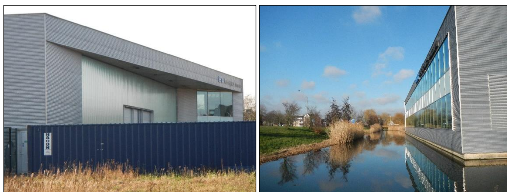
Figuur 7. Het gebouw naast het terrein van Senior Aerospace Bosman BV.
