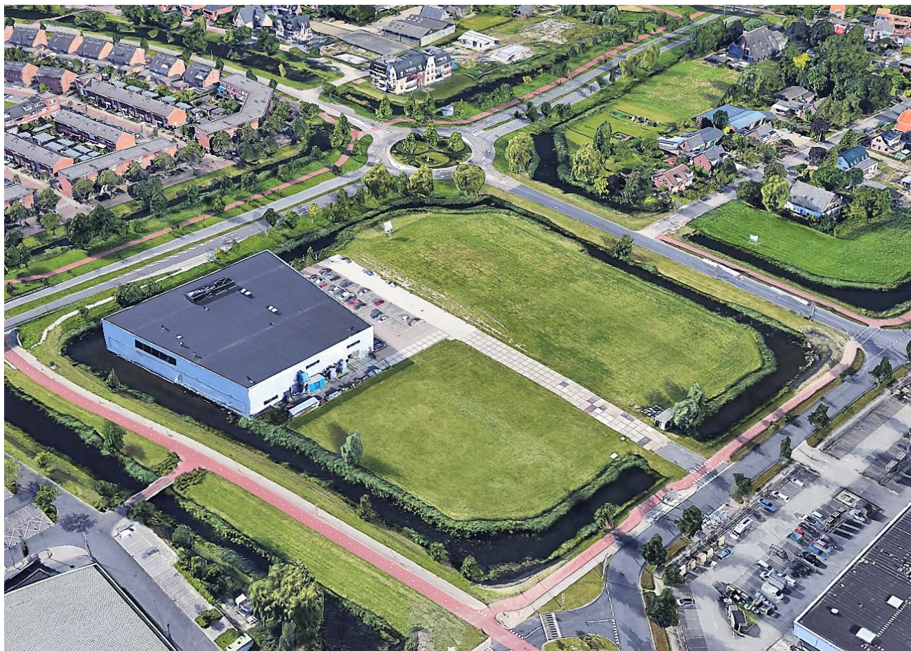
foto situatie richting noordwest
