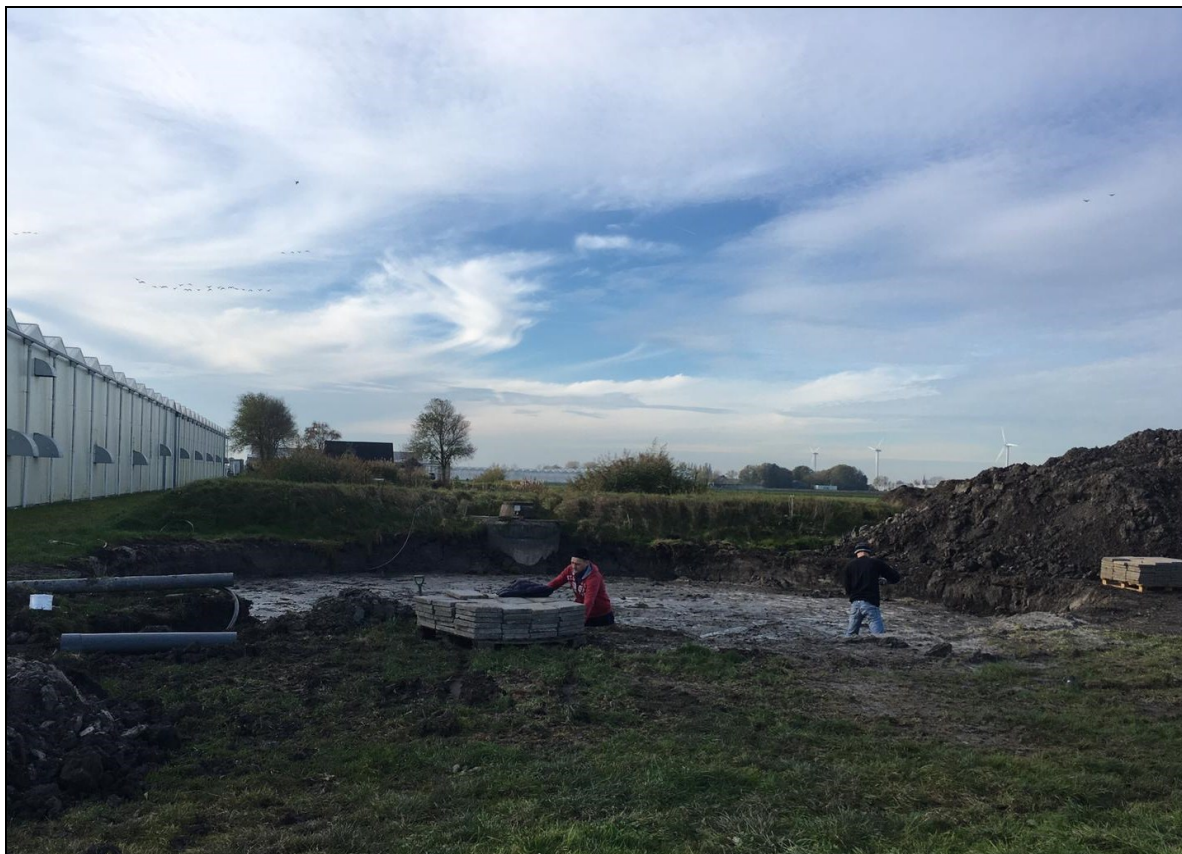
Afbeelding 10. De waargenomen graafwerkzaamheden achter de bebouwing op het perceel Vleetweg 1.
