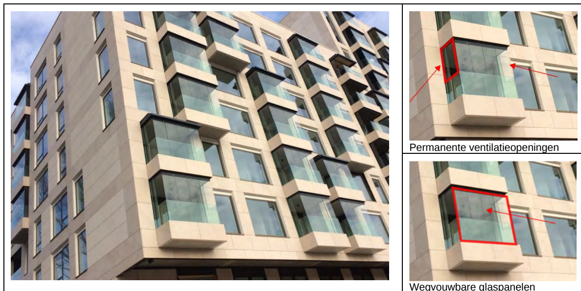
Figuur 5.2: Verglaasde balkons in project DeFred020 in Amsterdam
