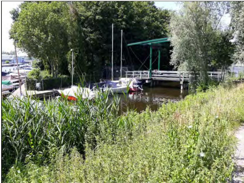
35 Wandel/fiets ophaalbrug aan de Jachthavenweg.
