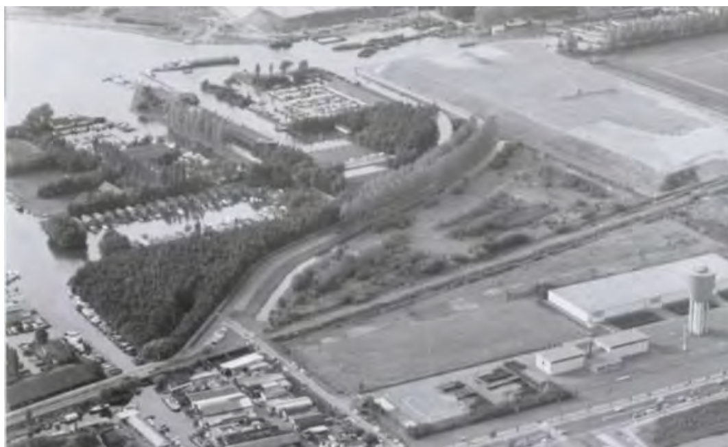
Jachthavens in noordwestelijke richting met rechts op de voorgrond het Pompstation van de Gemeentewaterleidingen. Diagonaal de spoorlijn en daarachter het Punterspad en het Jachthavengebied. Op de achtergrond het dijklichaam van de toekomstige Ceintuurspoorbaan. (SAA: 010009015657)
