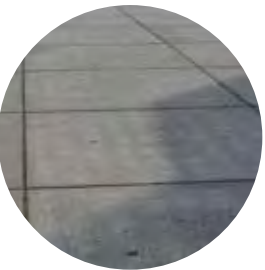
Stelconplaten, 2.0 x 2.0m, en 2.0 x 1.0m, beton
