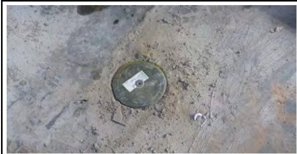
AFWERKING PEILBUIS 405-B
