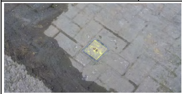
AFWERKING PEILBUIZEN 404 (A-B)
