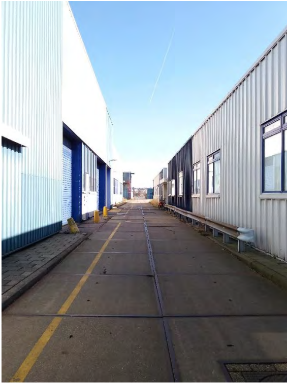
Figuur 3-4 bijgebouwen (rechts) (paars omkaderd in figuur 2-1). Aan de linkerkant is een gedeelte van de fabriekshallen te zien
