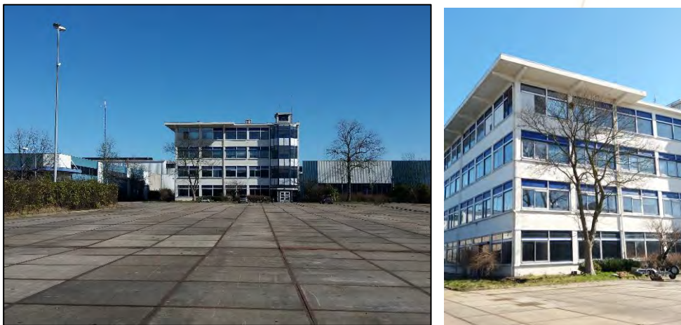
Figuur 3-2 kantoorgebouw Draka-terrein tegen de fabriekshallen (groen omkaderd in figuur 2-1)
