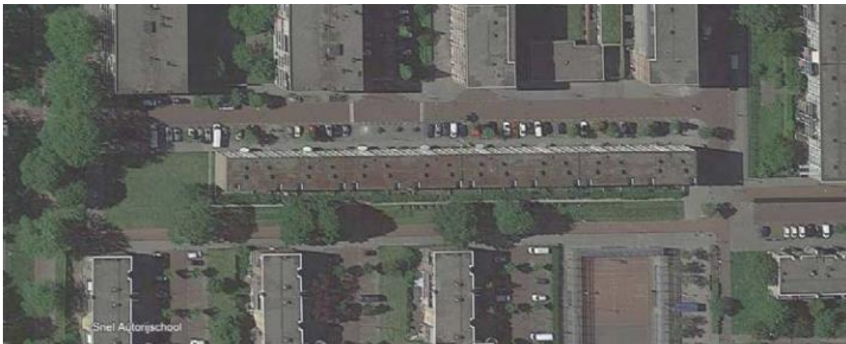
Bovenaanzicht van het gebouw aan de Nierkerkestraat
