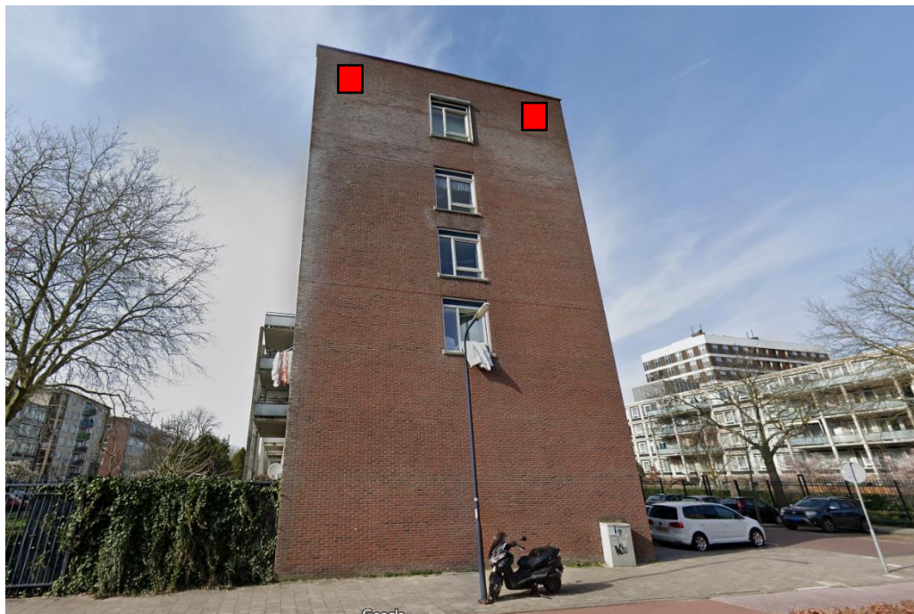
Figuur 8. Zuidgevel complex Hertingenstraat 42 tm 96 (kraamverblijven)
