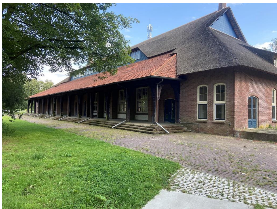
Foto 1: De voorzijde van de turnhal (noordwest).
