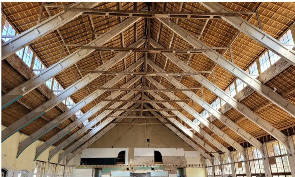
Figuur 1 – Monumentale kap van de voormalige SS Turnhal na de restauratie.
