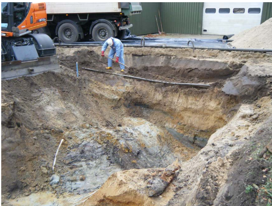
Ontgraving fase 1 (in westelijke richting; vrijgraven kabels)
