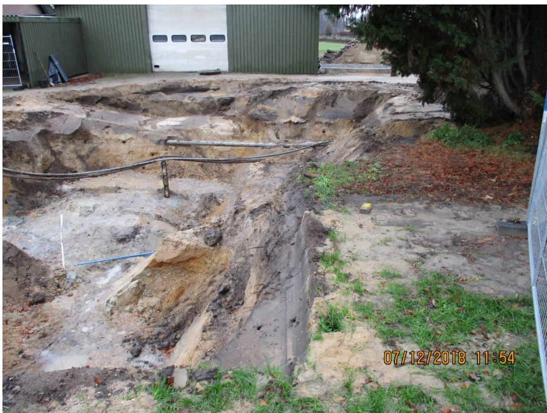
Ontgraving fase 2 (richting westen, op achtergrond schuur)
