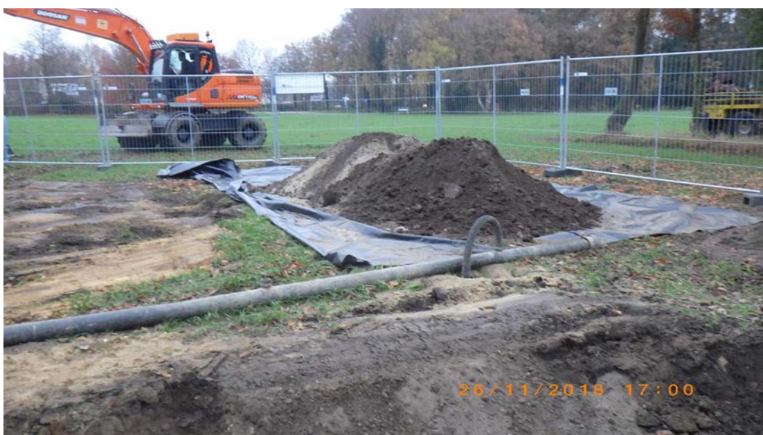
Ontgraving fase 1 (In oostelijke richting; depot twijfelgrond)
