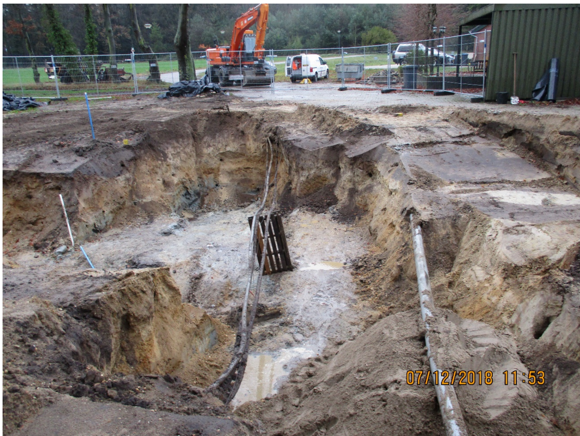
Ontgraving fase 2 (In zuidelijke richting; op achtergrond woning en tuin)
