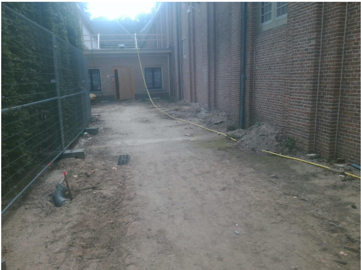
Foto F5 en F6: Partij 06 en 10, , terreindeel inpandig; , terreindeel achterzijde bebouwing;
