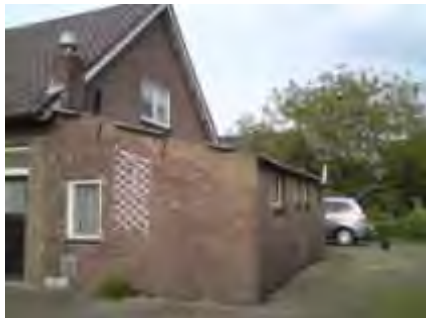
Zicht op de westelijke zijgevel en achtergevel van de woning.
