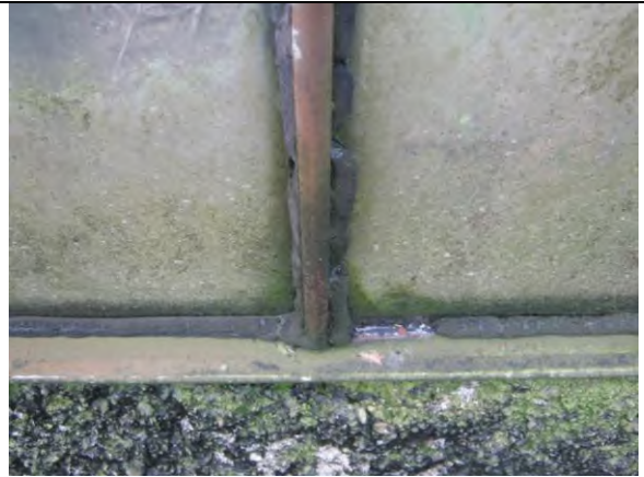
Foto 4: detail kitnaden kit M1 - asbesthoudend
