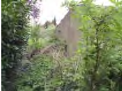
Achterzijde schuur met verhoogd maaiveld door gestorte grond.
