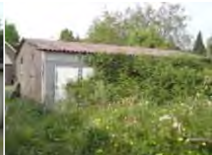
Achterzijde garage met verhoogd maaiveld door gestorte grond en sterk begroeid met onkruid.
