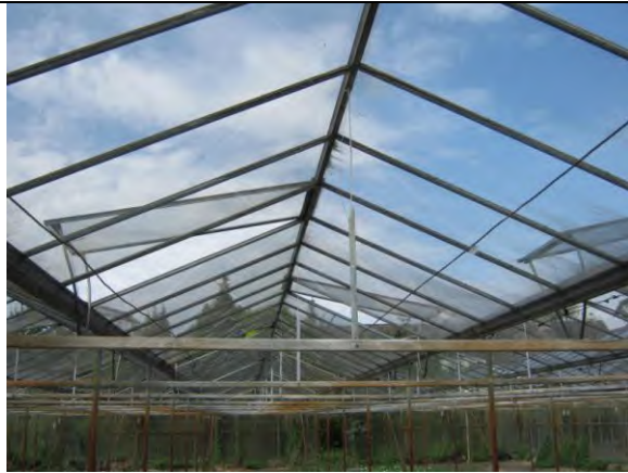
Foto 3: dak kit M1 - asbesthoudend
