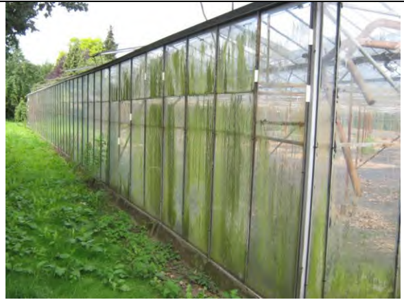
Foto 2: aanzicht langzijde kit M1 – asbesthoudend
