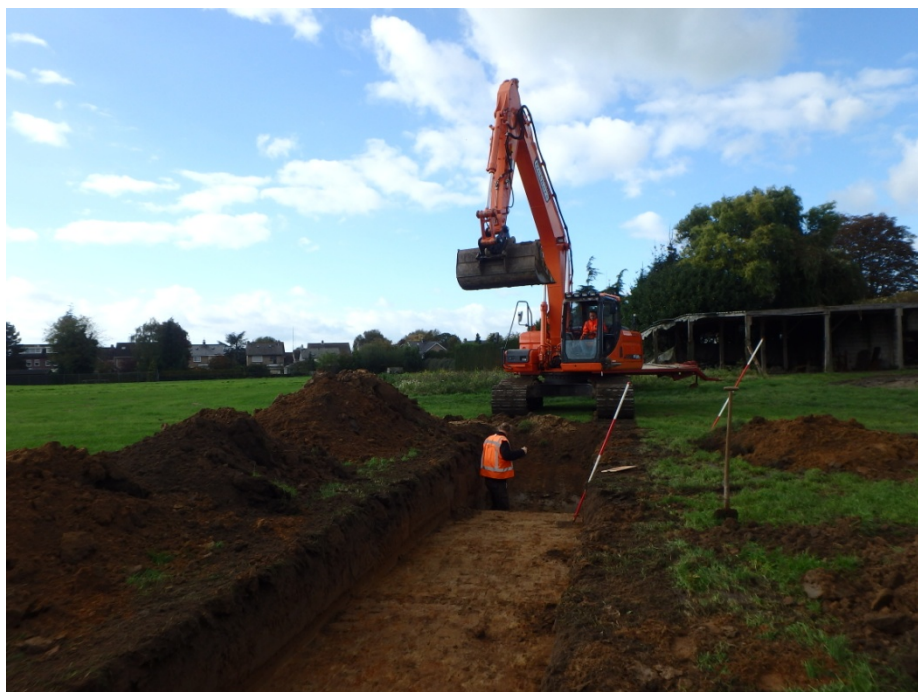
Afb. 1. Het aanleggen van een proefsleuf.
