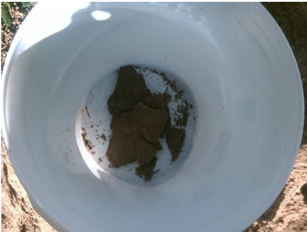
Foto 79. Asbestverdacht (plaat)-materiaal sleuf S4-25
