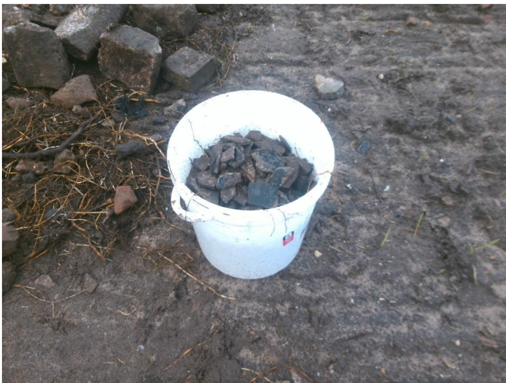
Foto 50. Asbestverdacht (plaat)-materiaal sleuf S4-08
