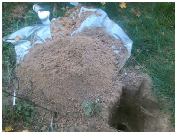
Foto: Inspectiegat A28
