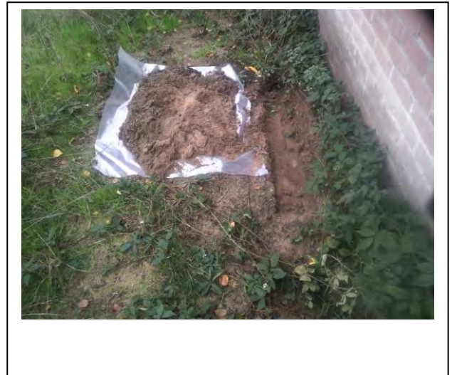
Foto: Inspectiegat B53
