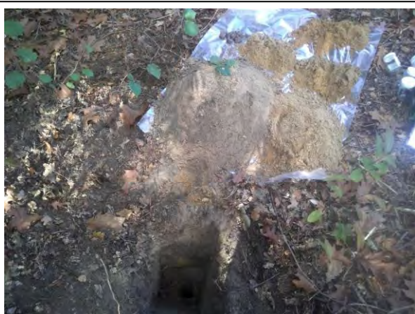
Foto: Inspectiegat A38
