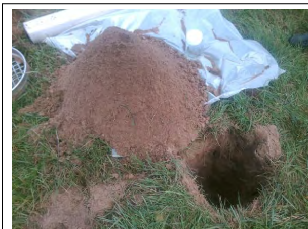
Foto: Inspectiegat A27
