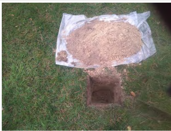
Foto: Inspectiegat B31
