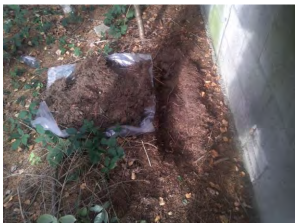
Foto: Inspectiegat E03
