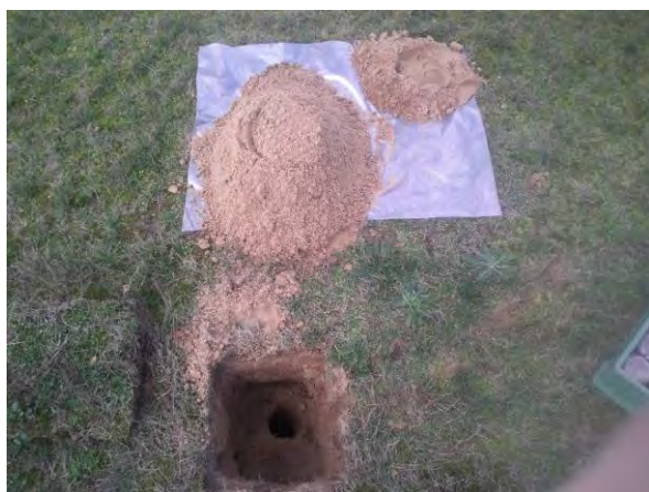
Foto: Inspectiegat B28
