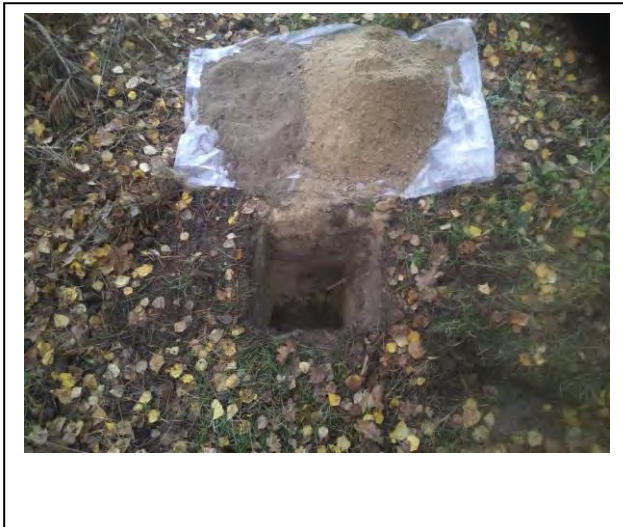
Foto: Inspectiegat B52
