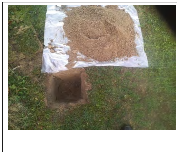
Foto: Inspectiegat B39
