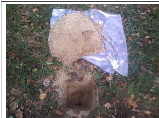
Foto: Inspectiegat A31
