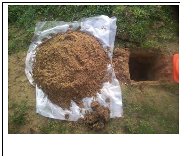
Foto: Inspectiegat B45
