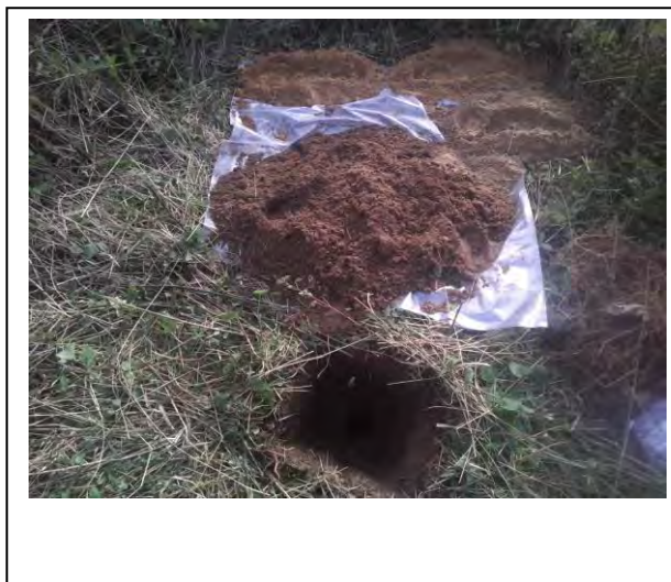
Foto: Inspectiegat A15
