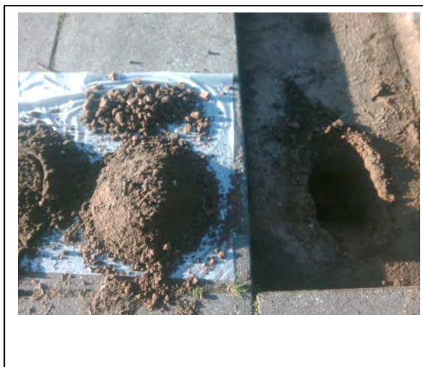
Foto: Inspectiegat A13
