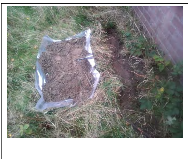
Foto: Inspectiegat G03
