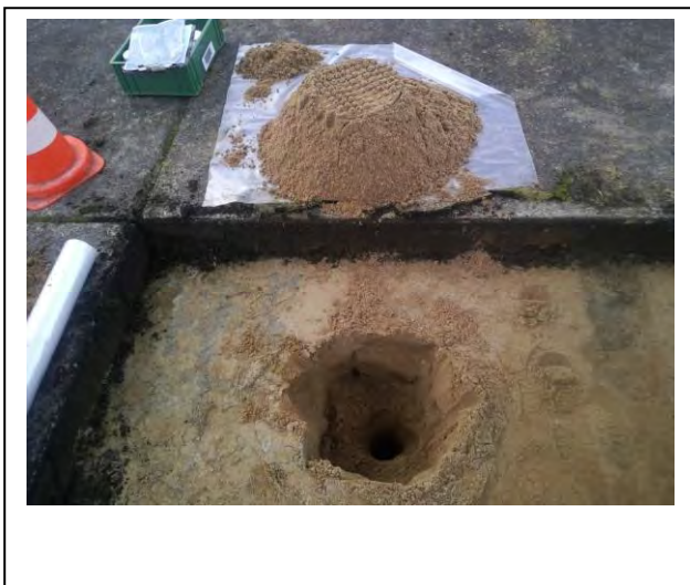
Foto: Inspectiegat B14
