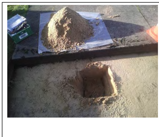
Foto: Inspectiegat B19
