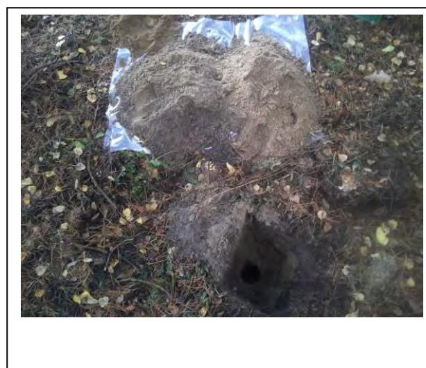
Foto: Inspectiegat B37
