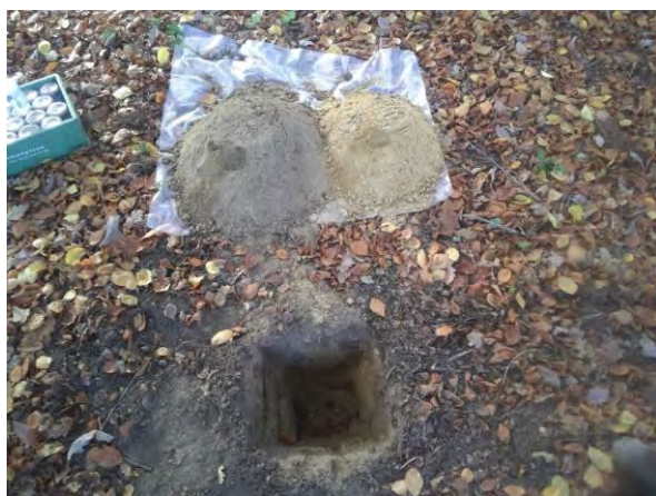
Foto: Inspectiegat A35
