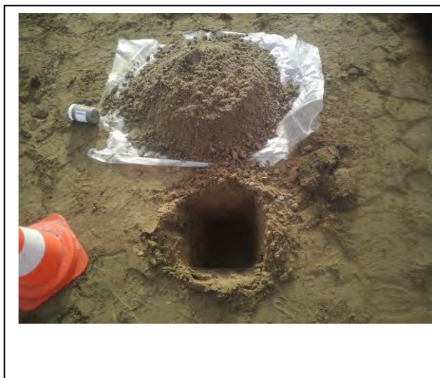
Foto: Inspectiegat B49
