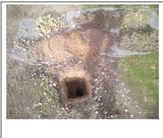
Foto: Inspectiegat B32
