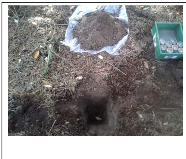
Foto: Inspectiegat B11
