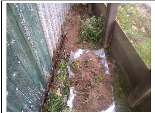
Foto: Inspectiegat I04
