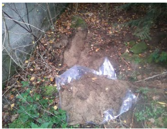
Foto: Inspectiegat E04
