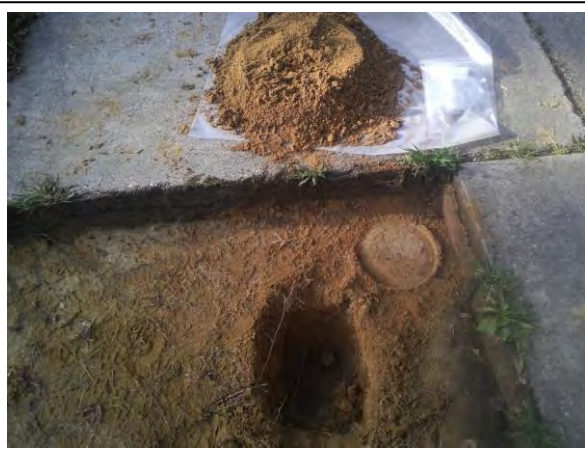
Foto: Inspectiegat A26
