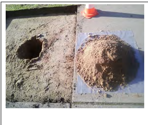
Foto: Inspectiegat B44
