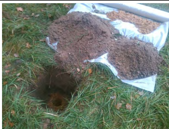
Foto: Inspectiegat A34
