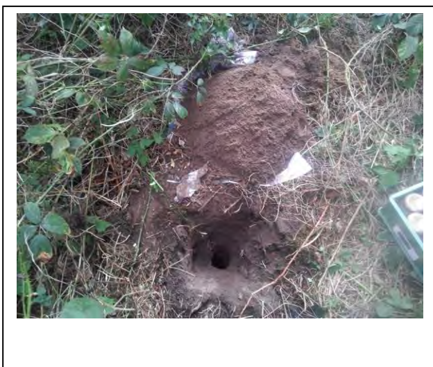
Foto: Inspectiegat B18
