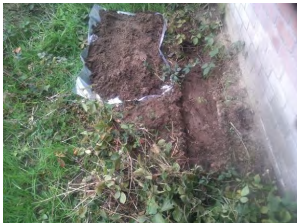
Foto: Inspectiegat H02
