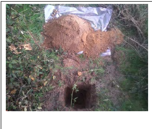
Foto: Inspectiegat A10
