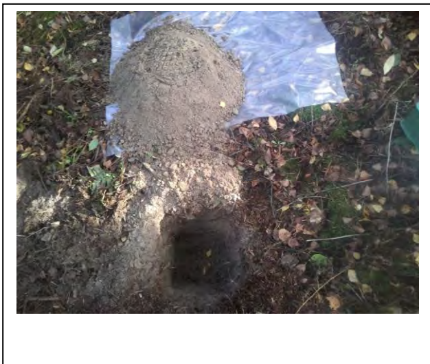
Foto: Inspectiegat B22
