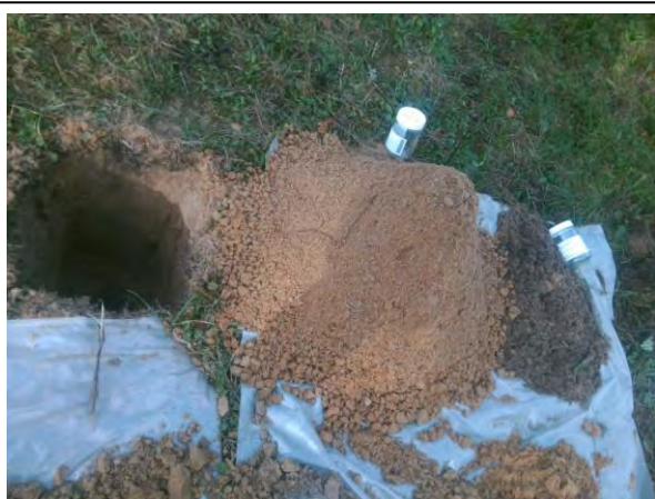
Foto: Inspectiegat A25
