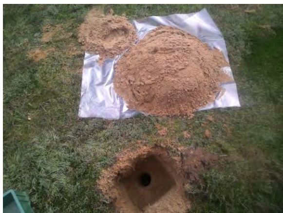
Foto: Inspectiegat B27
