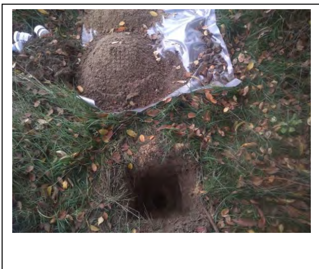
Foto: Inspectiegat A12
