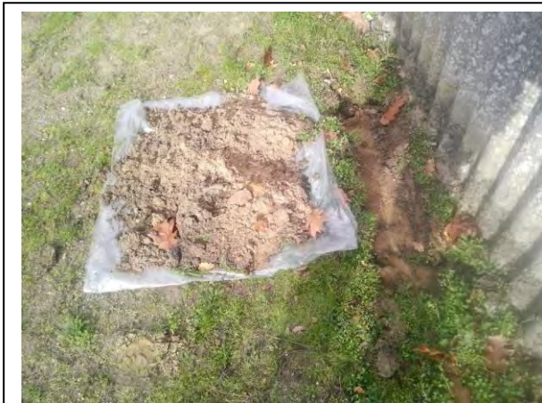
Foto: Inspectiegat I03
