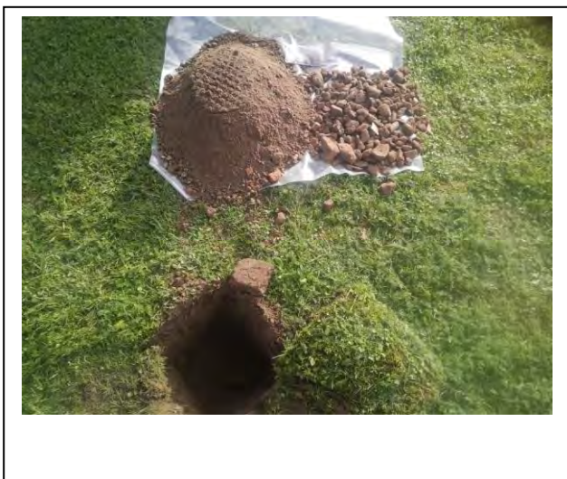
Foto: Inspectiegat B10
