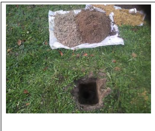
Foto: Inspectiegat B50
